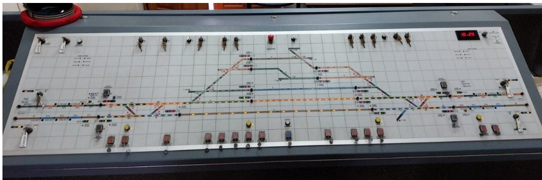
Εικόνα 4: Κάτοψη/ Φωτογραφία Τοπικού Πίνακα Χειρισμών και Οπτικών Ελέγχων Τύπου Ψηφίδας
