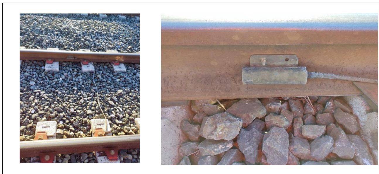
Εικόνα 17: Πυκνωτές Κυκλωμάτων Γραμμής- Φίλτρα αντιστάθμισης 30-32μF
