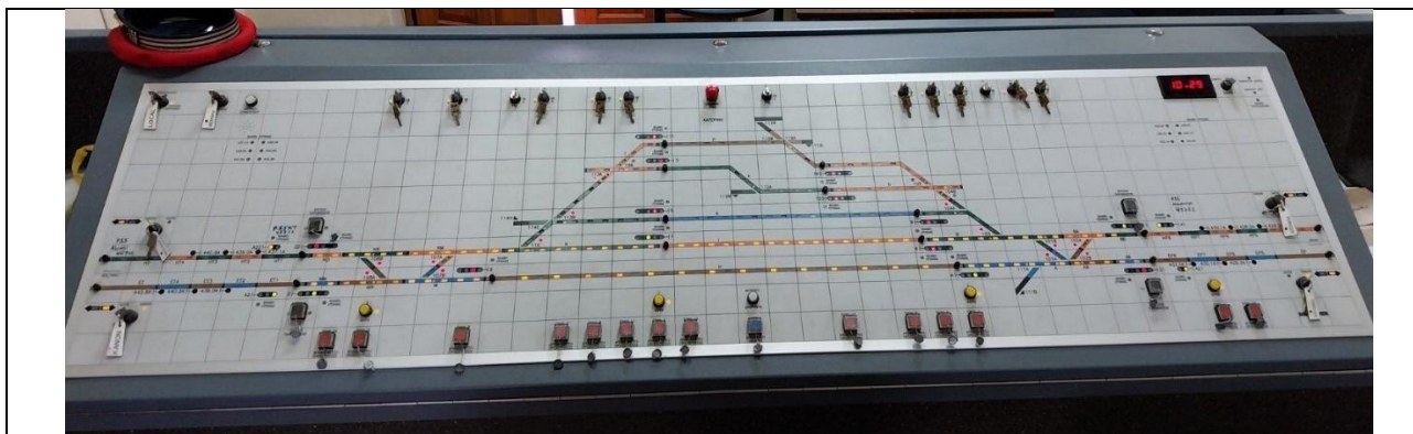
Εικόνα: Κάτοψη/ Φωτογραφία Τοπικού Πίνακα Χειρισμών και Οπτικών Ελέγχων Τύπου Ψηφίδας
