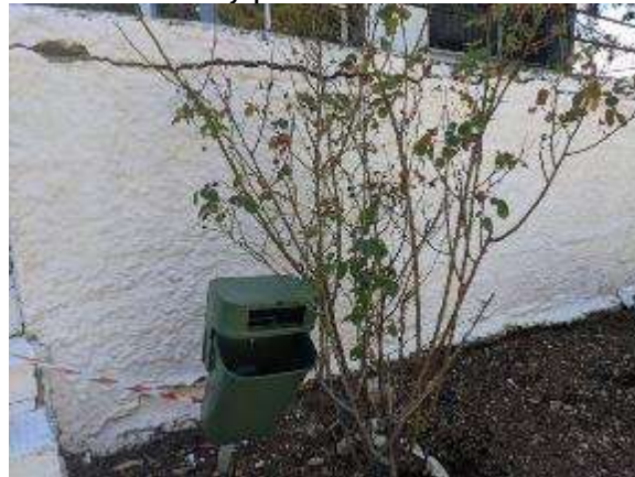
Διαμήκης ρωγμή στον προαύλιο χώρο (ξερολιθιά) με κίνδυνο ολίσθησης.
