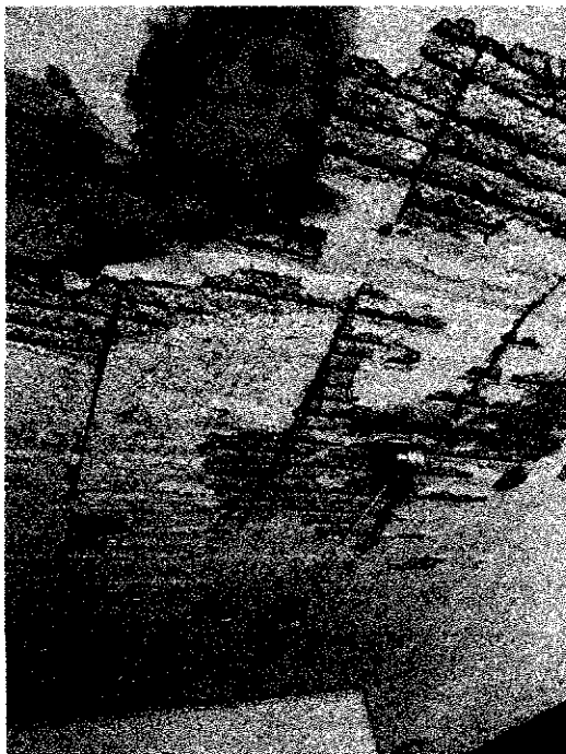
Σχήμα 2. Υφιστάμενες βλάβες πλακών Ω/Σ: Εκτεταμένη αποκάλυψη οπλισμού
