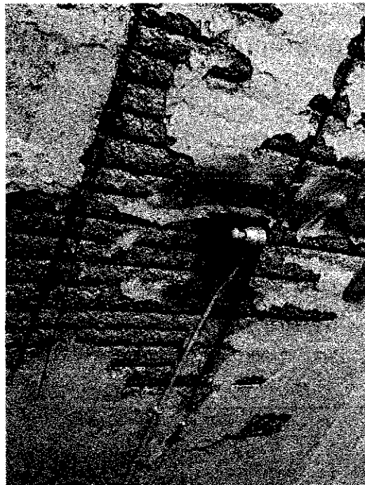
Σχήμα 2. Υφιστάμενες βλάβες πλακών Ω/Σ: Εκτεταμένη αποκάλυψη οπλισμού
