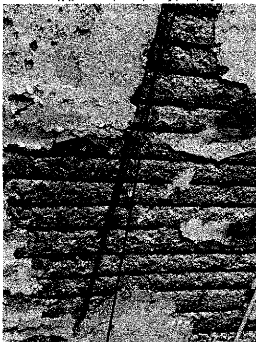
Σχήμα 3. Υφιστάμενες βλάβες πλακών Ω/Σ: Οξείδωση και αποκόλληση οπλισμού
