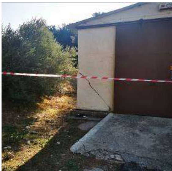
Αποκόλληση Τοιχοποιίας.
