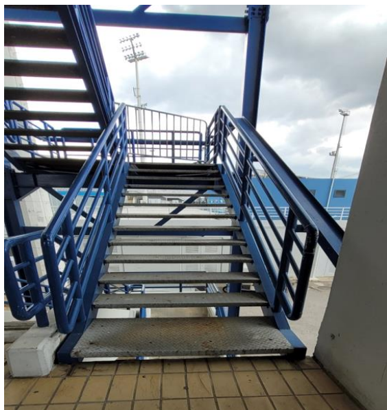
Υφιστάμενη σκάλα του Ανοικτού Κολυμβητηρίου
